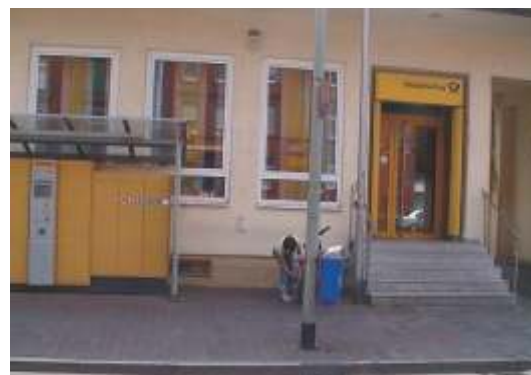
Eine große Gruppe von Mitbürgern kann die Niederräder Postfiliale nicht benutzen da sie die Räume nicht betreten kann. Behinderte, Kranke und ältere Mitbürger. Frankfurt hat über 50 000 schwer-behinderte Bürger (Stand 31.12.2006)
